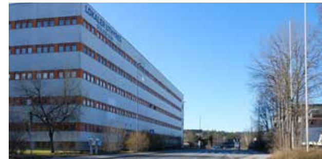
Kontorsbyggnad från 70-talet på Segersbyvägen. Den högsta byggnaden i området.
