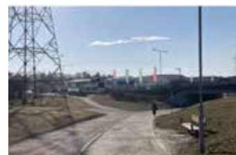
Passage under Hågelbyleden. Vy mot väst i riktning från Alby mot Eriksbergsdalen. Ramböll, 2022
