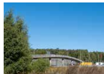
Gång- och cykelbron över E4/E20. Den enda passagen över motorvägen.
