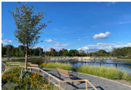
Dagvattendamm. Har flera funktioner utöver omhändertagande av dagvatten. Denna bild visar en nyligen byggd dagvattendamm i Fittja.
