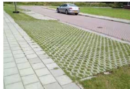
Armerat gräs. Kan användas istället för hårdgjorda ytor vid till exempel parkeringar. Det skapar möjlighet för vattnet att infiltreras genom marken och ger ett visuellt bättre intryck än asfalt.
